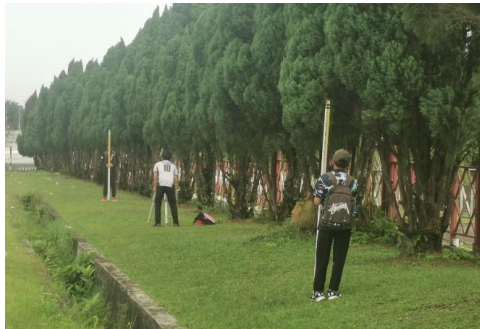
Rajah 1. Kerja Ukur Aras
